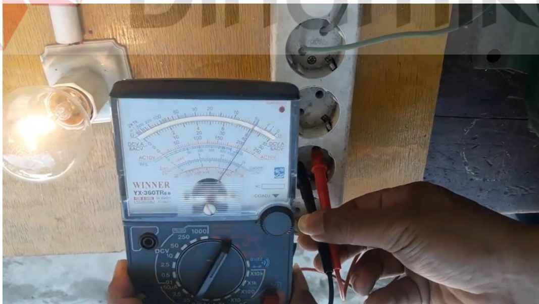
Gambar 4. 9 Colokan Kedua Probe Pada Colokan Listrik Dan Perhatikan Nilai
