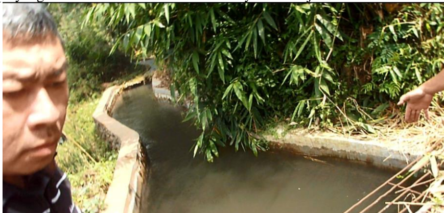
Gambar 2. Saluran masuk bak penenang 1 (existing)
