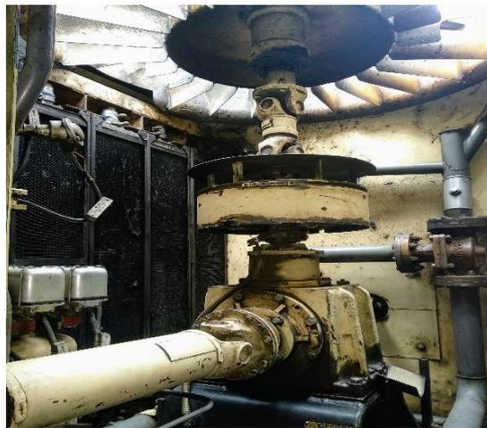
**Figura 27-2:** Acoplador electro magnético del ventilador de enfriamiento del refrigerante
