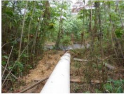
Ilustración 6 Canal de repartición de caudales PTAR Tibú
