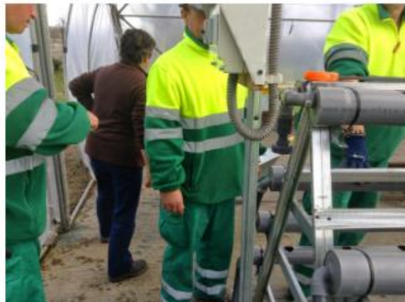
Figura 56: Comprobación del llenado de depósito de agua
