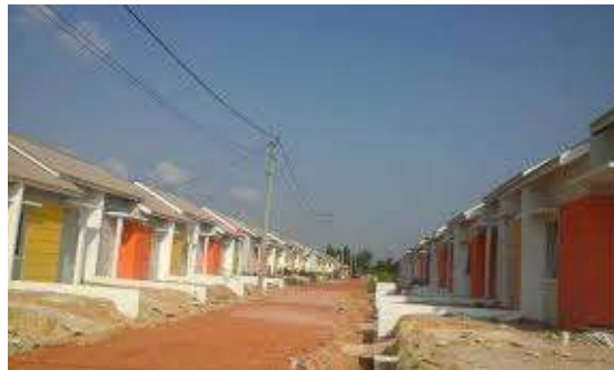
Gambar 1.1. Perumahan Marina Park
