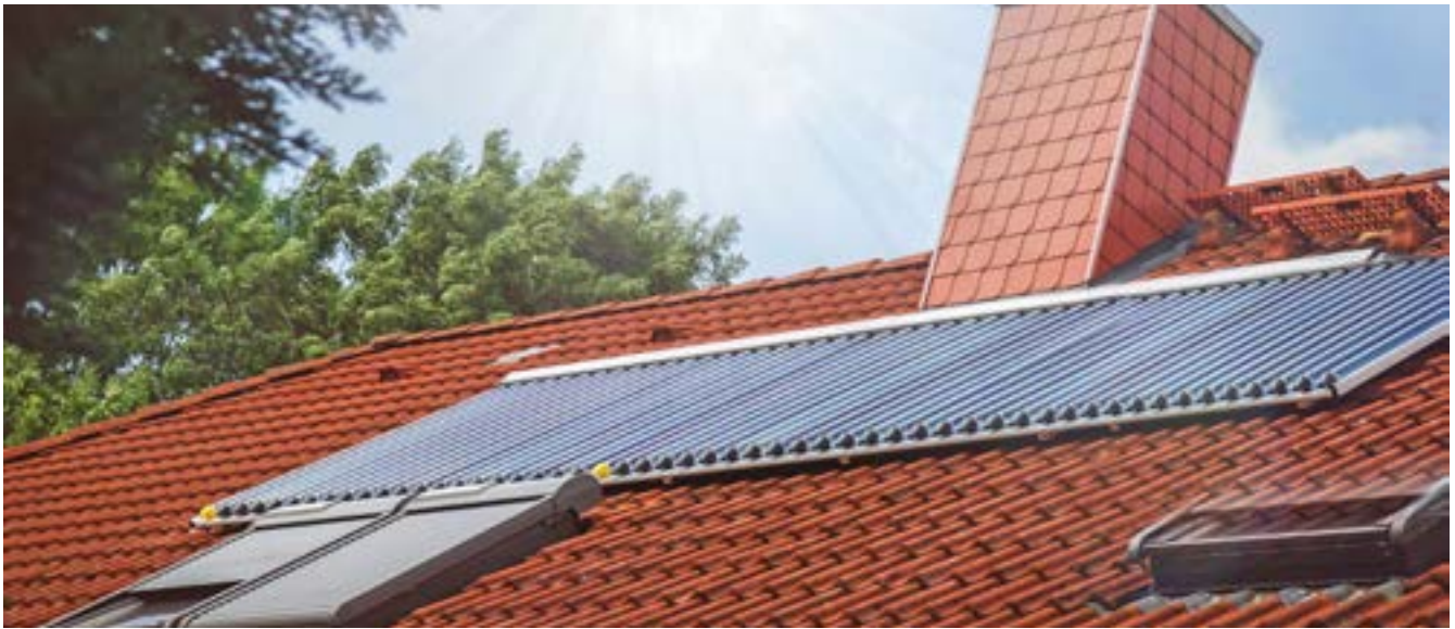
Effiziente Vakuumröhrenkollektoren erzielen heute auch bei ungünstigen Dachneigungen und -ausrichtungen eine gute Energieausbeute.
