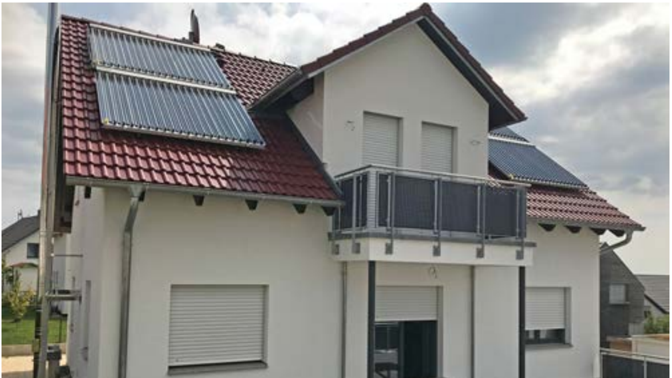
Moderne Solarthermie-Kollektoren auf dem Hausdach reduzieren nicht nur die jährlichen Energiekosten, sondern schonen auch das Klima und die Umwelt.
