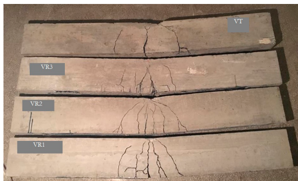
Figura 9 – Deformação das vigas após ensaio
