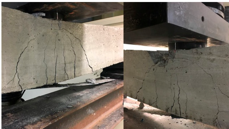
Figura 7 – Abertura de fissuras e descolamento do reforço da viga VR2
