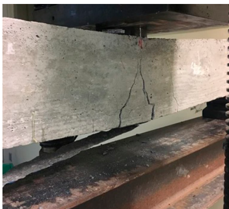
Figura 8 – Abertura de fissuras e descolamento do reforço da viga VR3
