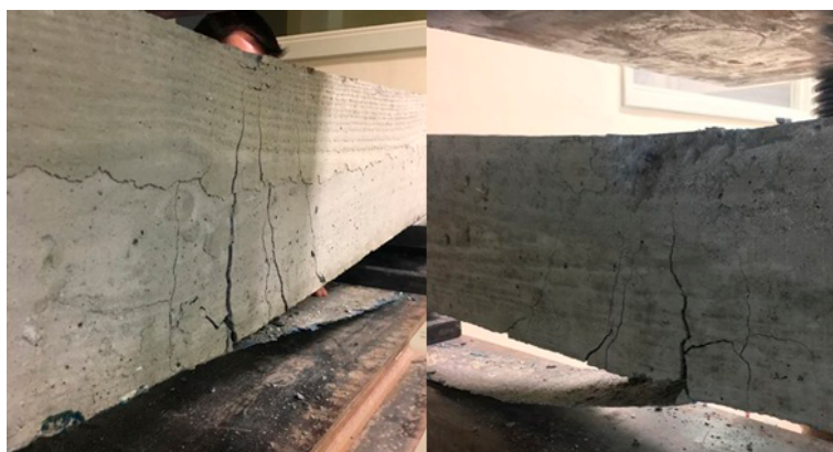
Figura 6 – Viga VR1 após o ensaio
