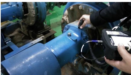
Gambar 11 Pengukuran Vibrasi pada Cooling Water Pump
