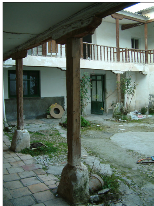
Foto 2. Vista del patio de una casa de vecinos en C/ Arenas de Daimiel, año 2005, desaparecida. Fotografía del autor.
