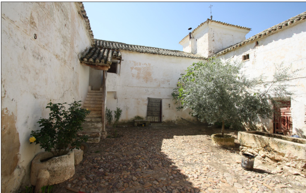
Figura 2. Venta de Borondo. Vista patio interior, 2012. Fotografía digital: David Cejudo
