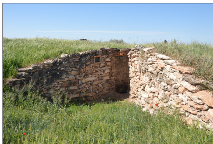
Figura 3. Vista de caleras en Cordel de los Moledores
