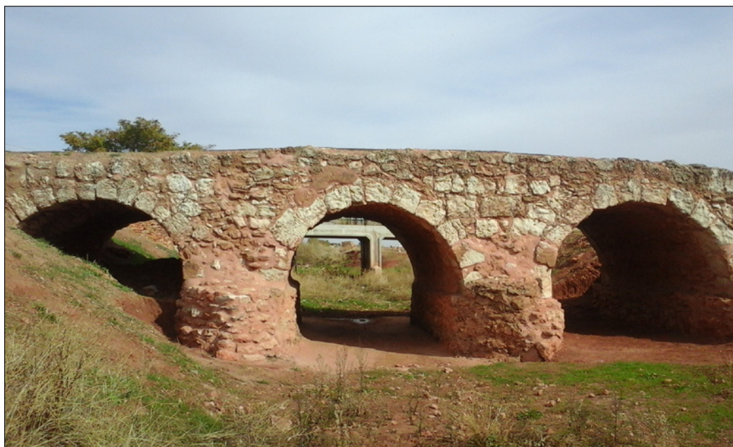
Figura 5. Fotografía del Puente Viejo del Azuer.
