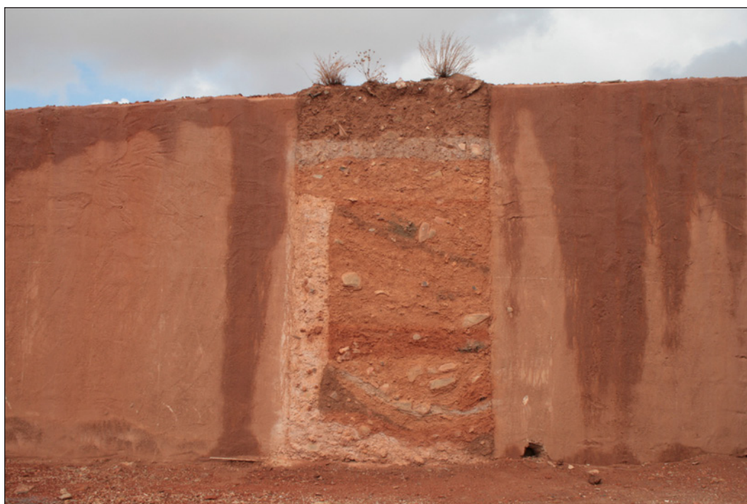
Fig. 6. Resultados visibles tras el proceso de hidrofugación de la superficie del perfil. Fotografía: M. Carmona (2017)
