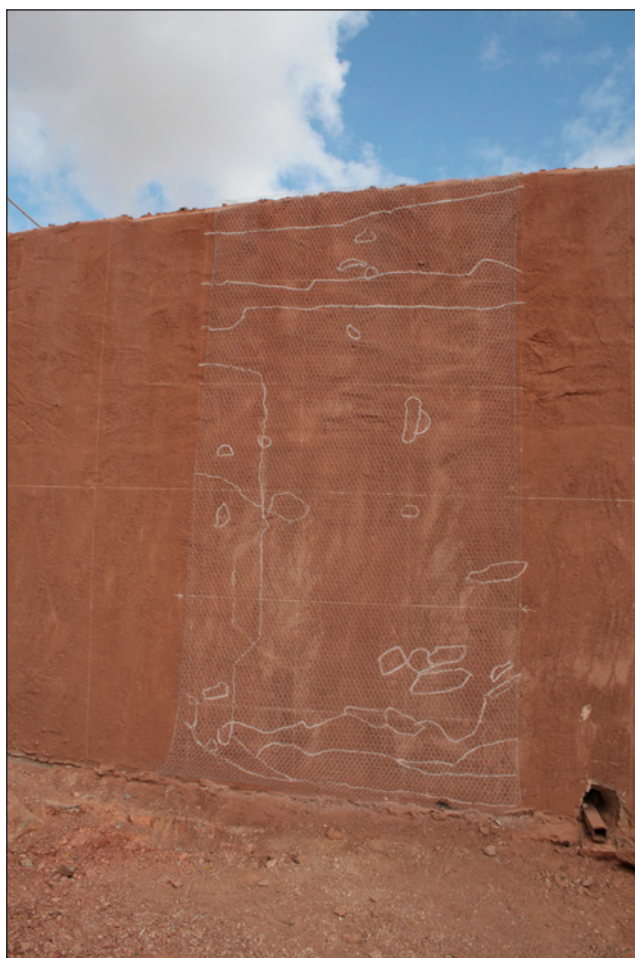
Fig. 4. Dibujo y colocación de la malla galvanizada. Fotografía: M. Carmona (2016)
