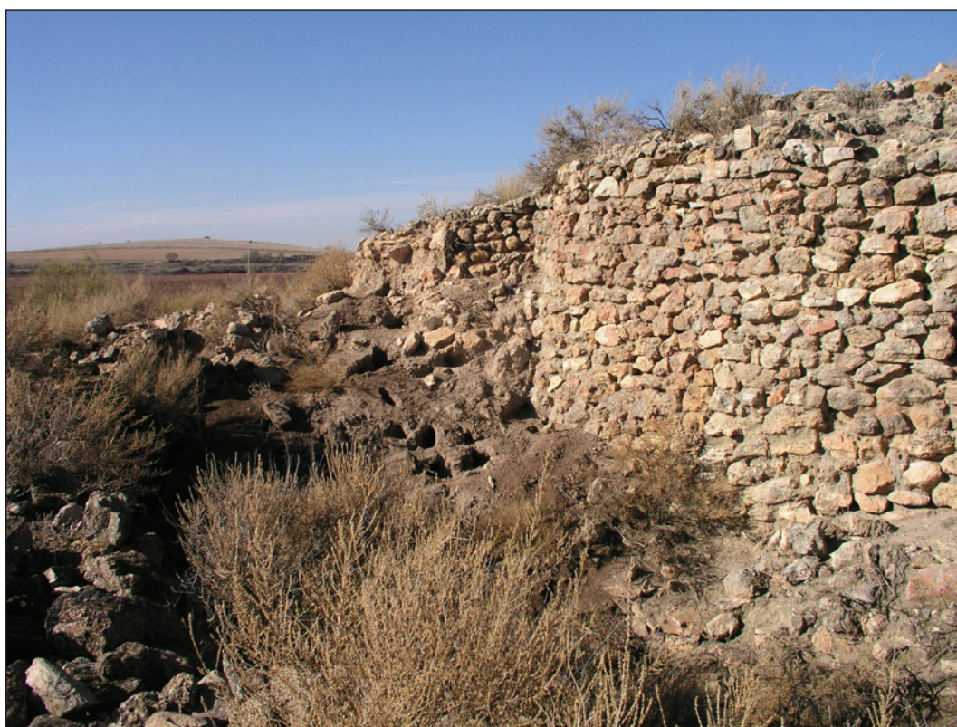
Figura 3. Estructuras murarias visibles del corte “A” de la Motilla del Retamar. (Fuente: archivo personal).
