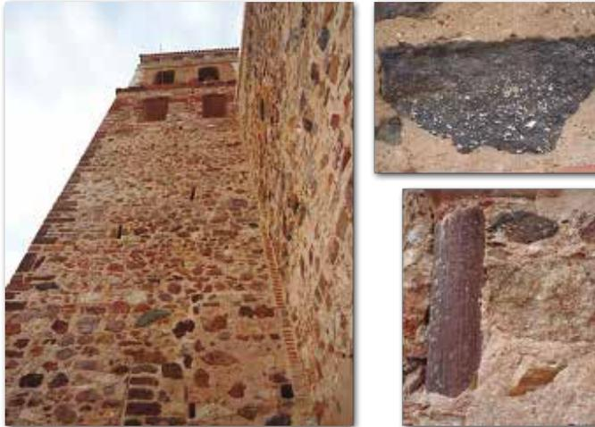
Figura 26. a) Vista de la Torre del Campanario de la Iglesia Visitación de Nuestra Señora. b) Detalle de un bloque de basalto. c) Columna de arenisca, reutilización de material.
