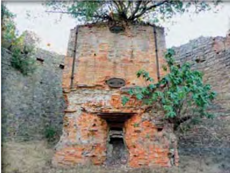
■ 6 Restos del horno de fundición de hierro del Martinete, Los Pozuelos de Calatrava.
