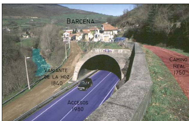
Fig. V.97.- Final de la hoz de Bárcena donde coinciden el trazado original del Camino Real, la variante de 1840 y el túnel de los Accesos.
