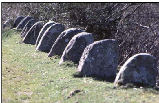
Fig. V.11.- Detalle de la sucesión de guardarruedas como sistemas de protección para los carruajes.
