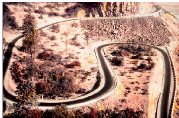
Fig. IV.18.- Rowena Loops en la Columbia River Highway. Se construyeron para tener suficiente desarrollo con una pendiente máxima del 5%.
