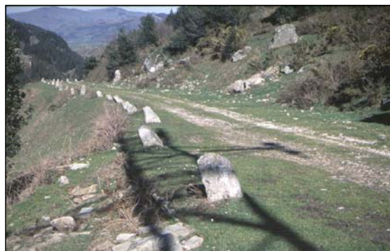
Figura V.9.- El mismo tramo a media ladera, obsérvese los guardarruedas, muros y desmontes.
