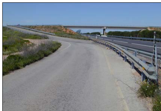
Fig. VI.85.- Foto actual de uno de los ramales de dicho enlace cerrado llevando el acceso hasta el enlace de Consolación para así reducir el número de enlaces en la autovía.
