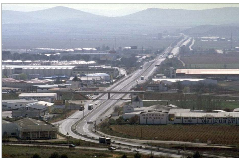
Fig. VI.55.- Imagen actual de la variante de Valdepeñas con vías de servicio para las actividades situadas sobre ella, y el polígono industrial entre la variante y la ciudad. El enlace norte no se aprecia por ser un paso inferior (compárese con la situación hace 30 años, Fig. VI.54a).
