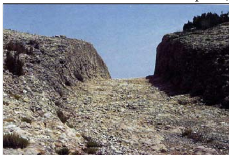
Fig. III.5.- Paso de Roca Tallada excavado por los romanos.
