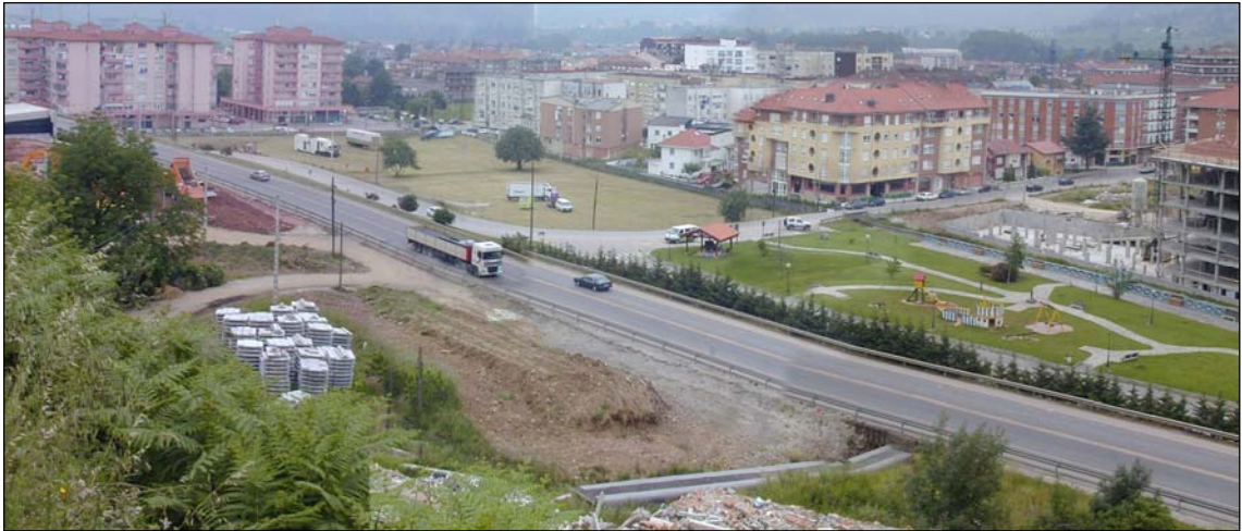
Fig. V.110.- Imagen de junio de 2002 con la autovía en construcción duplicando calzada de los Accesos. Obsérvese la colmatación del espacio entre los Accesos y el núcleo (parque, edificios nuevos y en obras).
