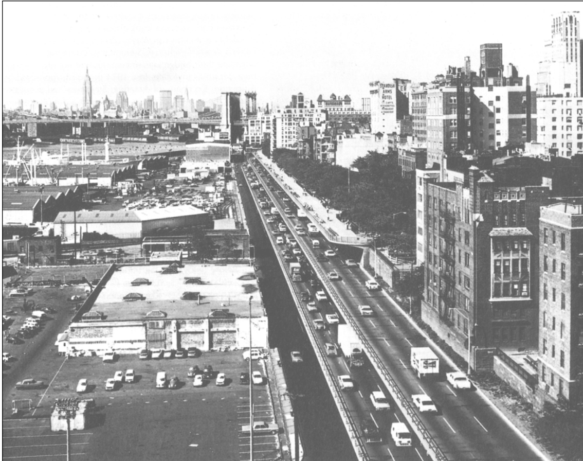
Fig. II.17.- Brooklyn – Queens Expressway, tramo en voladizo. Al menos el piso superior se destinó a zonas verdes.
