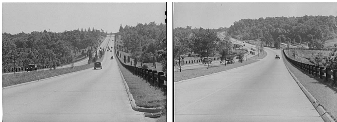
Figs. III.61 y III.62.-Dos imágenes de la Merrit parkway, construida en 1941 en Connecticut, donde se puede apreciar la influencia de las autopistas alemanas. Obsérvese la reducción de la mediana para el paso bajo la estructura del paso superior. Fuente: Biblioteca del Congreso, http://memory.loc.gov/ammem/ammemhome.html
