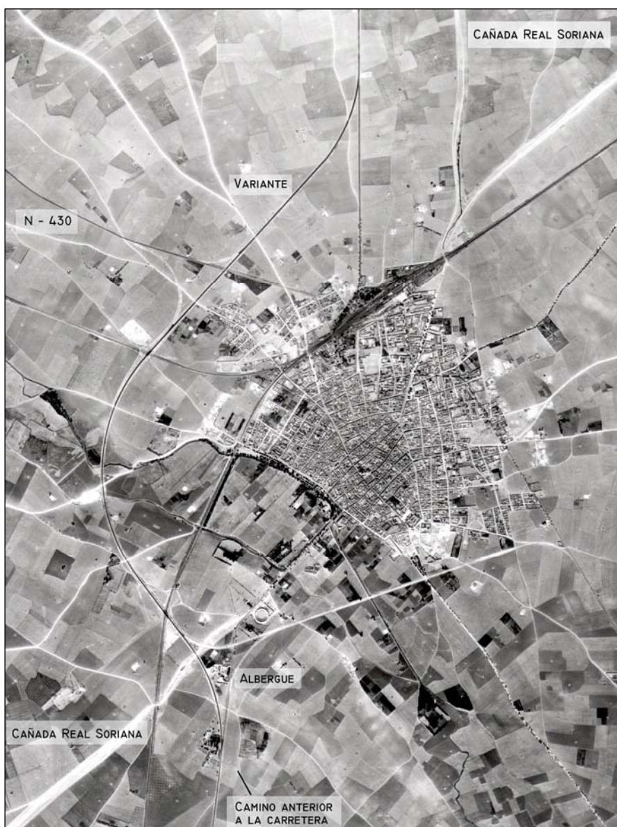
Fig. VI.29.- Fotografía aérea del vuelo americano (julio 1956) con la variante en construcción. Se observan claramente la Cañada Real Soriana y el ramal proveniente de Tomelloso, la barrera del ferrocarril, y el único espacio abierto al noreste, donde años más tarde se localizará el Polígono Industrial.
