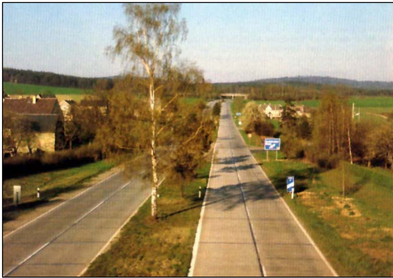
Fig. III.59.- Imagen de 1990 de la Autopista A4 en As Ohorn antigua RDA, que muestra el estado de conservación de las Autobahnen en el este. Obsérvese el arbolado en la mediana, la falta de arcenes, y el pavimento de hormigón. Fuente: Internet.
