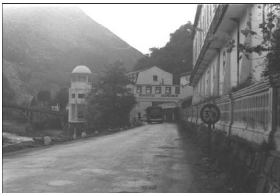
Fig. V.35.- Paso por el Balneario de las Caldas. el gálibo bajo la pasarela era de 3,8 metros. Obsérvese la pervivencia de los guardarruedas a la izquierda.
