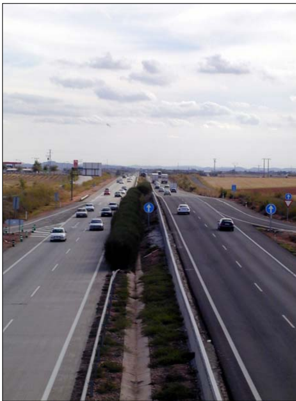
Fig. III.80.- Autovía por duplicación de calzada (la nueva a la izquierda) y enlaces a distinto nivel. Obsérvese la peor calidad del trazado en alzado de la calzada derecha, la correspondiente al REDIA..
