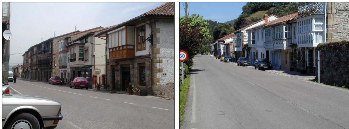
Figs. V.74 y V.75.- Dos ejemplos de crecimiento lineal sobre el Camino Real. A la izquierda Molledo, donde la carretera bordea el núcleo original (muy posible variante del XIX), a la derecha crecimiento a un solo lado en Santa Olalla. Obsérvese la relativa homogeneidad de las edificaciones en ambos casos.
