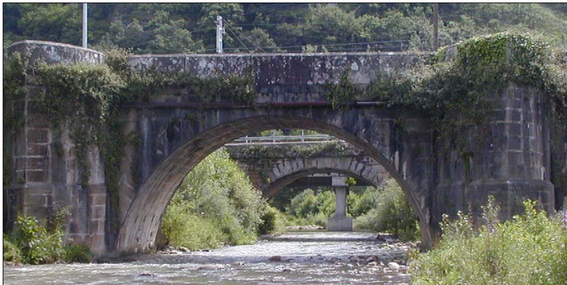
Fig. V.60.- Mientras que el puente del Camino Real sobre el río los Llares en las Fraguas, en primer término, y el puente del ferrocarril detrás, llega hasta la orilla, el puente de los Accesos va más separado, y sitúa sus pilas donde mejor conviene a la estructura, no al río.
