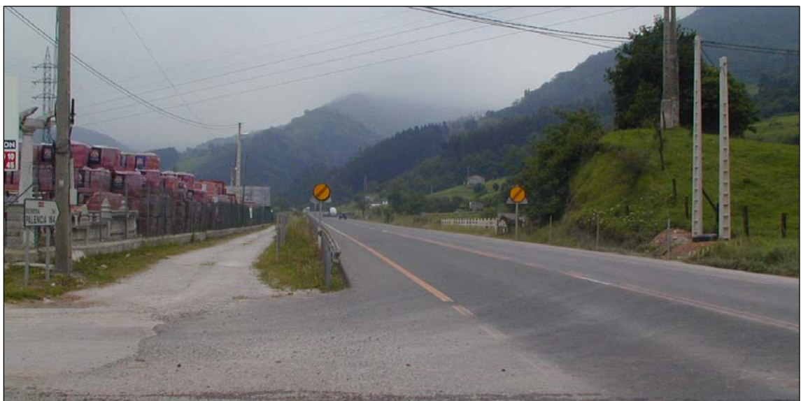
Fig. V.126.- Vista de los Accesos a su paso por el sur del valle de Buelna en dirección sur. Obsérvase el camino de servicio, cuyo cerramiento termina en este cruce a nivel, donde cruza el camino de Corrales a la Contrina. Puesto que los Accesos, en la charnela del valle no van en terraplén, no se pudo construir paso inferior para este camino, conservándose este cruce a nivel, junto al cual se ha ubicado una empresa de almacenaje de materiales de construcción (izquierda).
