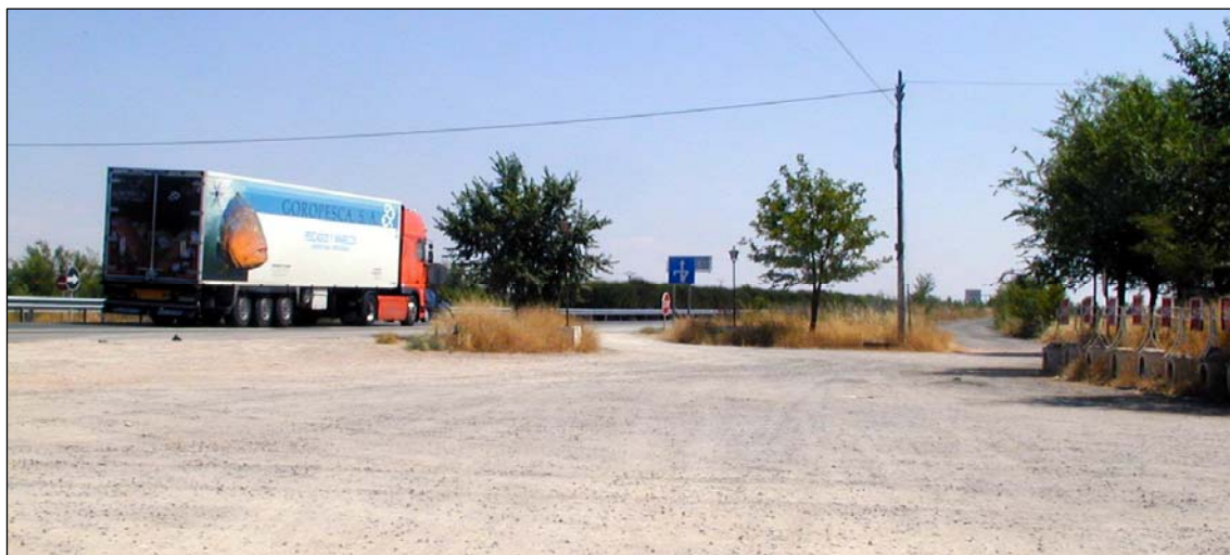
Fig. VI.80.- Acceso directo con stop a la autovía desde un restaurante (el camión está circulando por la autovía). Estos accesos suelen ser muy anchos para facilitar la aceleración e incorporación a la Autovía. Obsérvese a la derecha el camino de servicio para vehículos agrícolas.
