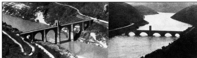
Fig. III.7.- Diferencia de nivel de aguas entre estiajes y crecidas que justifica la altura del puente de Alcántara.
