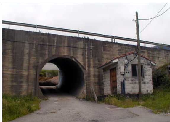
Fig. V.120.- Paso bajo los Accesos para comunicar Los Corrales con el Barrio de la Tusquía, situado sobre la ladera. Obsérvese lo poco ambicioso del diseño.
