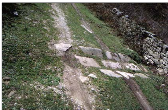
Fig. V.13.- Pequeño badén para drenaje en el trazado de la hoz de Bárcena.
