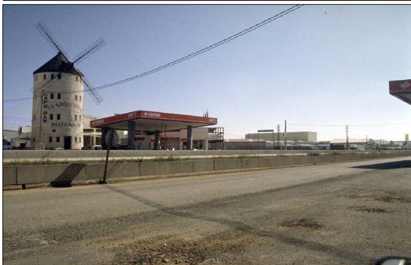
Fig. VI.56.- Algunos de los servicios situados sobre la variante. En primer término la vía de servicio. Obsérvese la mediana estricta.
