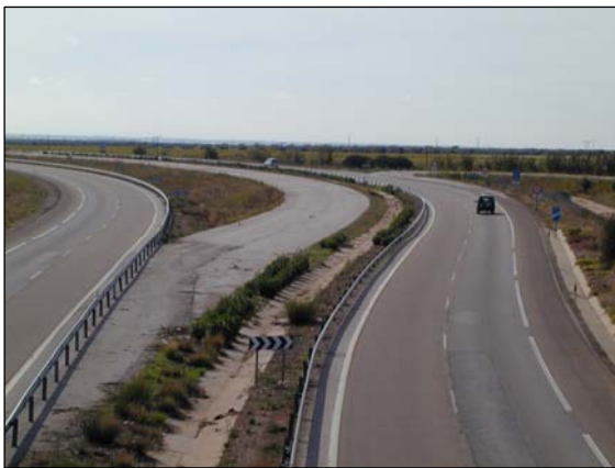
Fig. VI.71.- Entronque de la variante de Puerto Lápice, rectificación de la calzada izquierda para conectar con el siguiente tramo de autovía.
