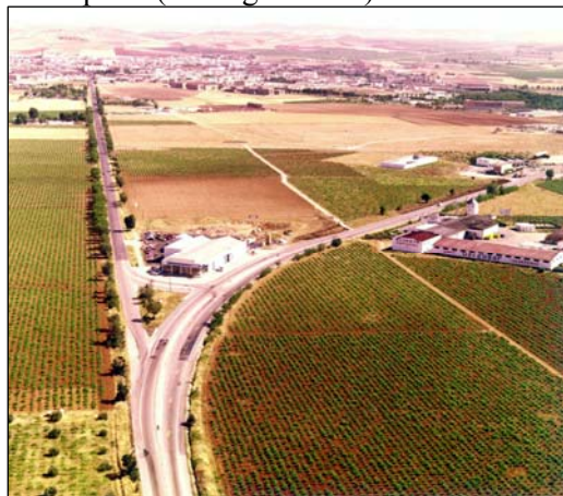
Fig. VI.54a.- Intersección norte de la variante de Valdepeñas antes de la construcción de la avenida del vino en el tramo abandonado de carretera (en la imagen flanqueado por árboles), y de la duplicación del calzada. Obsérvese la colonización de la variante, así como el gran espacio disponible entre la variante y el núcleo.
