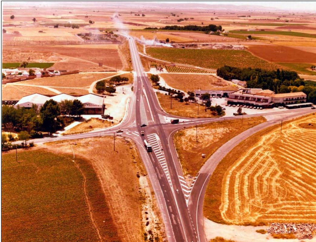
Fig. VI.43.- Intersección oeste entre la variante de Manzanares de la N-IV y la N – 430 una vez realizadas las obras de canalización de intersecciones en la Nacional (Proyecto de 1962). Obsérvese el inicio de la colonización de la variante (hotel, puesto de la Cruz Roja y, enfrente, gasolinera y naves), y como hay suficiente espacio para la duplicación de calzada, pero no así para la construcción de enlaces ortodoxos.
