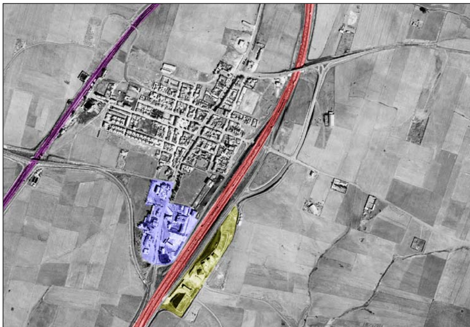
Fig. VI.92.- Duplicación de la zona de servicios de Almuradiel. La zona de servicios sobre la carretera REDIA (azul) ya sólo sirve para la dirección sur, mientras que, tras la construcción de la variante, se ha construido una nueva zona de servicios (en amarillo) sobre el ramal de salida hacia Almuradiel, que a servicio a la dirección norte
