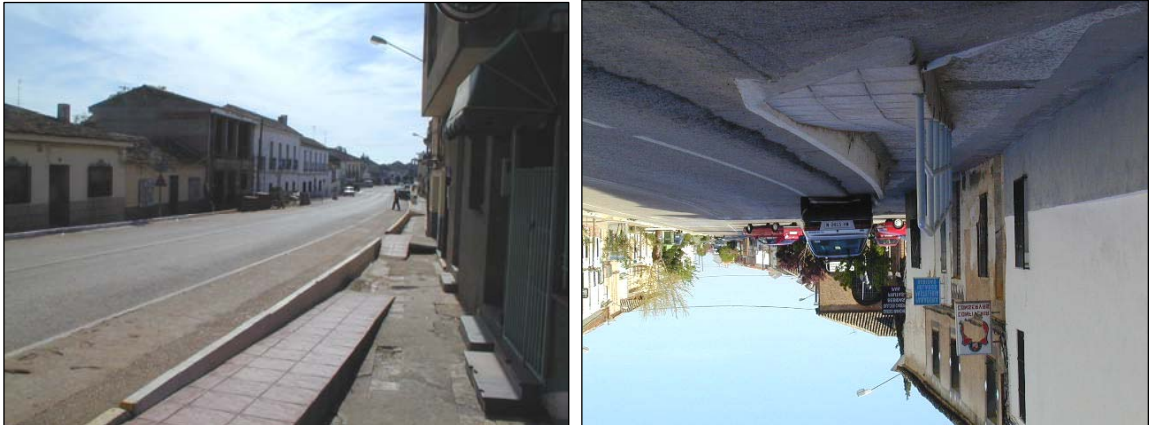
Figs. VI.37 y VI.38.- Supertravesía de Puerto Lápice. Obsérvese las diferencias de cota entre los edificios y la calzada como consecuencia de peraltes, drenaje y trazado en planta de la travesía.
