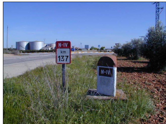
Fig. VI.72.- Tramo de la carretera abandonado, cruce con el ramal de conexión con la N-420. Los depósitos del fondo (Larios) condicionaron el trazado para pasar por detrás.
