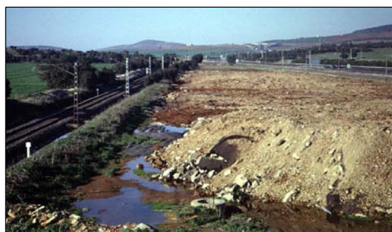
Fig. VI.82.- Franja de terreno residual entre el ferrocarril y la Autovía, utilizada como vertedero.
