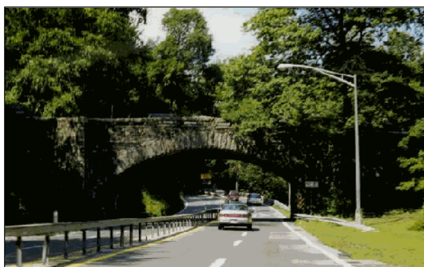
Fig. III.42.- Bronx River Parkway en la actualidad, adaptada a las exigencias del tráfico moderno, pero con estructuras de pasos superiores que delatan las intenciones paisajísticas del diseño original.
