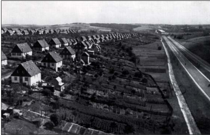
Fig. III.63.- Utopía Nacionalsocialista llevada a la realidad: conjunto residencial junto a la autopista en Chemnitz en 1937. Se observa como la residencia y la autopista corresponden a diseños distintos, aunque dependiendo la primera de la segunda. Fuente: SHÜTZ, E y GRUBER, E., "Mythos Reichautobahn", 1996, p. 153.
