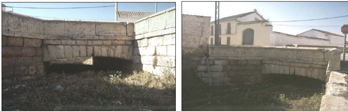
Figs. VI.20 y VI.21.- Pontón a la entrada de Santa Cruz de Mudela, de arco sorprendentemente plano e imposta típica del XVIII.
