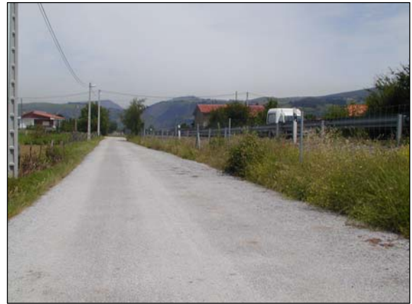
Fig. V.125.- Camino de servicio que concentra los caminos existentes hacia el paso. Al fondo, el cruce del tendido eléctrico de la figura V.122.
