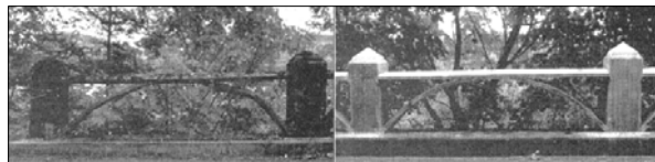
Fig. IV.13.- Barreras de la Columbia River Highway, antes y después de la restauración.
