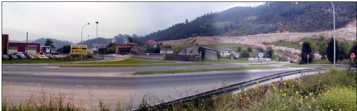
Fig. V.107.- Intersección de Barros, con el desarrollo industrial conectado a la izquierda, y restaurantes y servicios de la carretera (centro). Al fondo, las obras de al Autovía.
