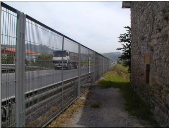
Fig. V.124.- Pese al cerramiento para evitar el cruce de los peatones (siguiendo el antiguo camino) éste ha sido cortado por los vecinos para abrir un paso.
