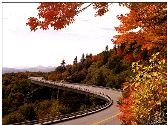
Fig. III.46.- Viaducto Linn Cove en el paso de la Blue Ridge Parkway por la Gran Father Mountain.
