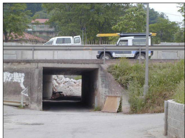
Fig. V.90.- Paso bajo los Accesos, peatonal y para vehículos ligeros entre San Mateo y su iglesia. Detrás la segunda calzada de la Autovía en construcción.
