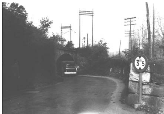
Fig. V.34.- Paso bajo el ferrocarril en Molledo. El gálibo quedaba en menos de 3,5 metros.
