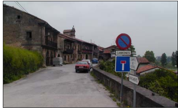
Fig. V.101.- Travesía de Riocorvo, transformada tras al construcción de los Accesos en un fondo de saco.
