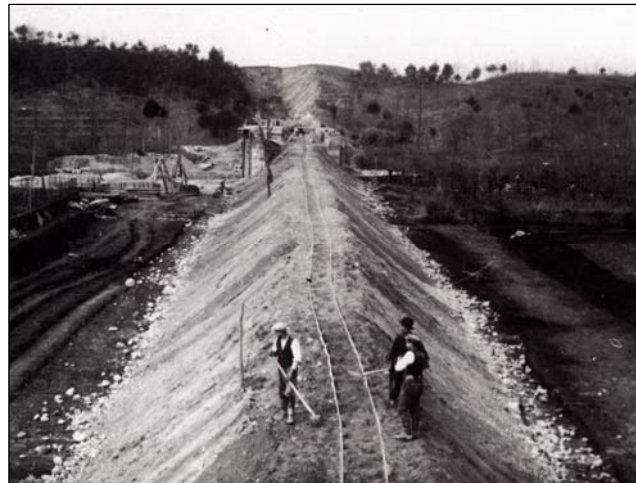
Fig. III.51.- Construcción de un terraplén y desmonte al fondo, para mantener la línea recta en la autoestrada Milán – Los lagos.. Fuente: AA.VV. 1924 – 1935. Le autostrade della prima generazione , p.44.
