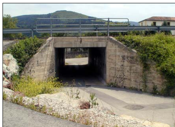
Fig. V.121.- Paso bajo los accesos junto a la intersección de Helguera. De nuevo, el gálibo queda restringido para vehículos ligeros.
