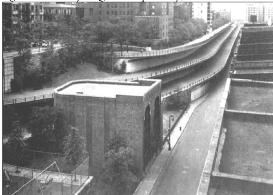
Fig. II.18.- Brooklyn – Queens Expressway, tramo en voladizo antes de abrirse al tráfico.
