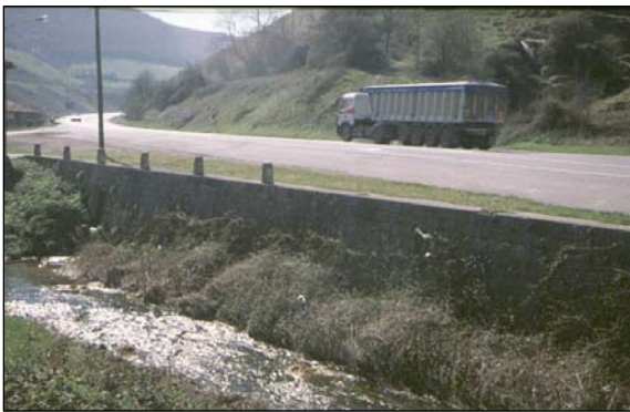
Fig. V.117.- Muro junto al Besaya del Camino Real poco antes del comienzo de la hoz de Bárcena. Por la calidad de su sillería, probablemente corresponda a la reconstrucción del Camino.
