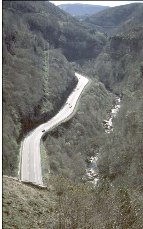
Fig. V.44.- Los Accesos en la Hoz de Bárcena. Obsérvese la posición respecto al río, así como las ligeras rectificaciones respecto al trazado inicial de la variante (zonas con hierba junto a los muros).
