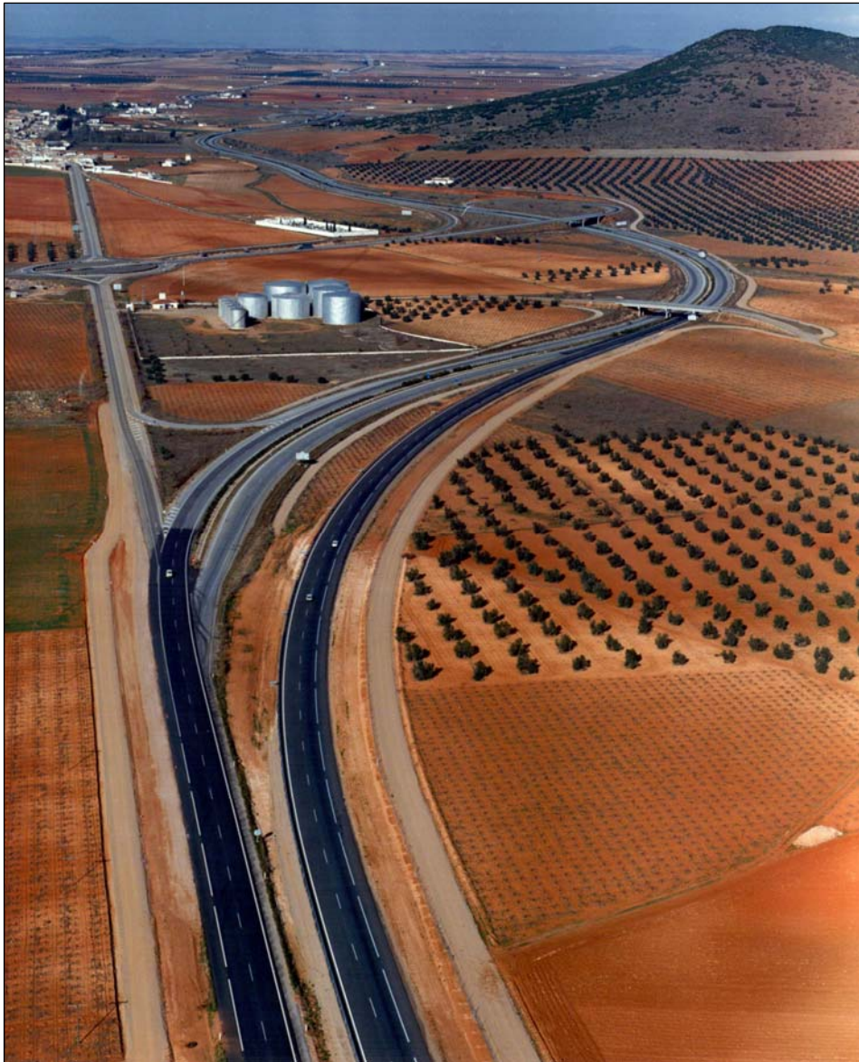
Fig. VI.73.- Variante de Puerto Lápice desde el sur. Obsérvese la influencia del cementerio y las bodegas en su trazado y en el del ramal de la N – 420. Además, la rectitud del trazado del siglo XVIII, los caminos de servicio, y el desplazamiento de la calzada izquierda por la construcción del siguiente tramo de autovía (Puerto Lápice Sur – Manzanares Norte), con radios mínimos menores, y dejando una gran porción de terreno inútil en la mediana.
