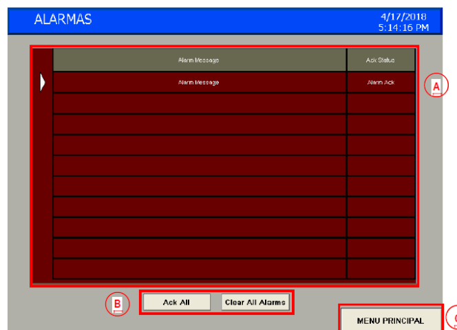
Pantalla de alarmas de SCADA.
