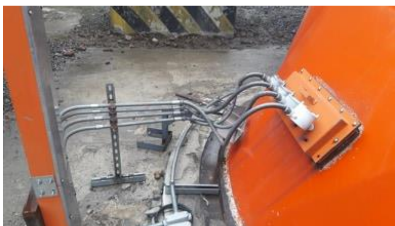
Fotografía N° 3. Conexiones realizadas en los troncales.
