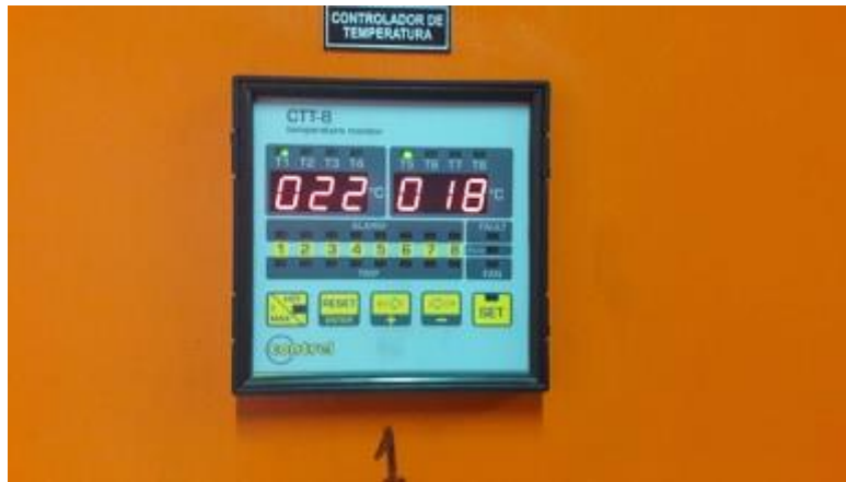
Fotografía N° 10. Panel de control de la temperatura de los motores.
