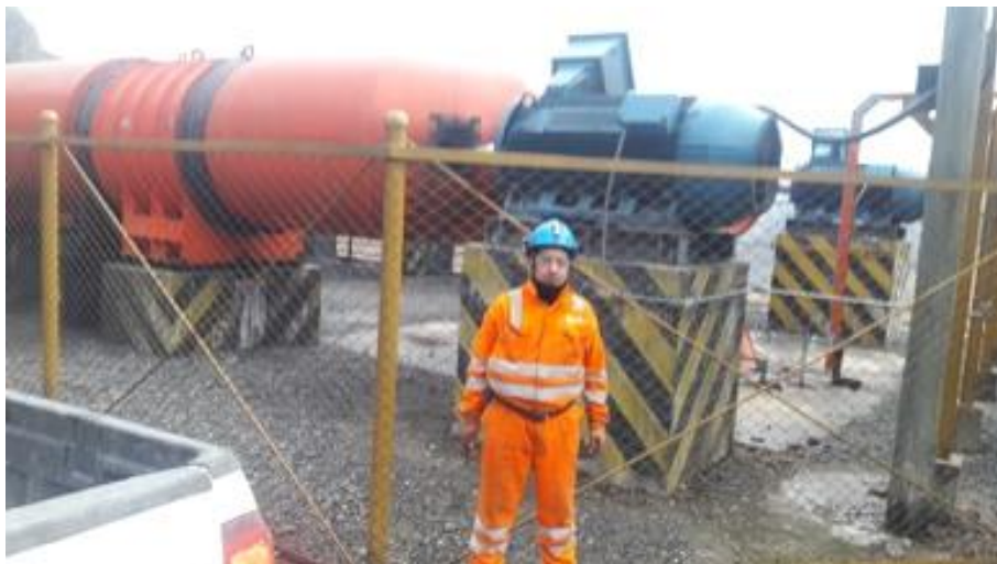
Fotografías N° 11 y 12. Evidencia objetiva con la presencia de los troncales y motores del sistema de ventilación, considerando los equipos de protección personal adecuados para la labor.
