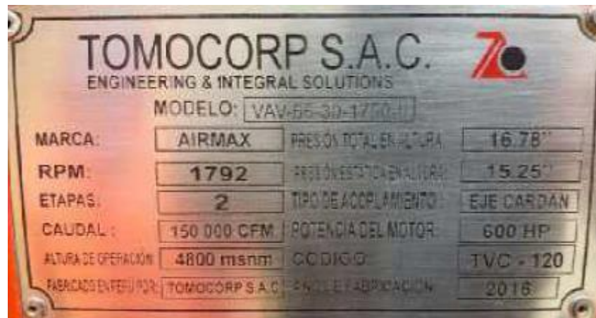
Placa de características del ventilador.
