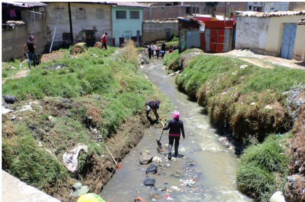
Figura 4. Descolmatación del río Chilca
