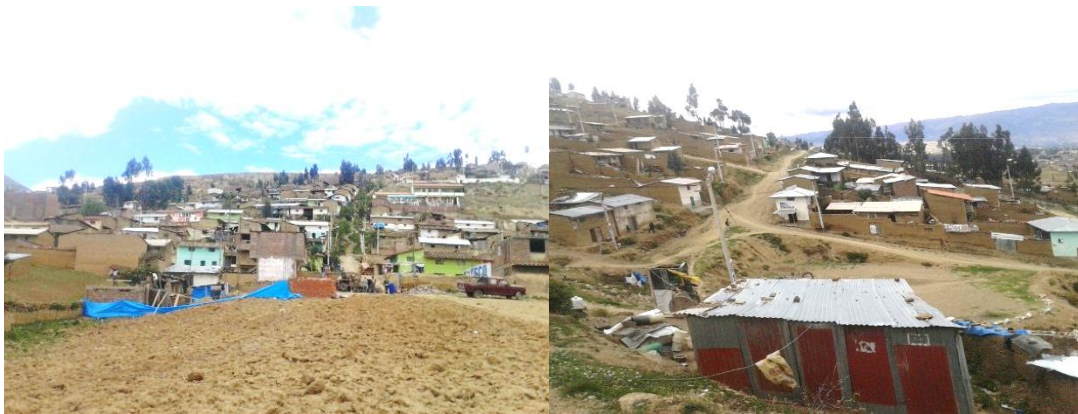
Figura 2. Viviendas vulnerables a sismo en el sector la Esperanza Fuente: Elaboración propia
