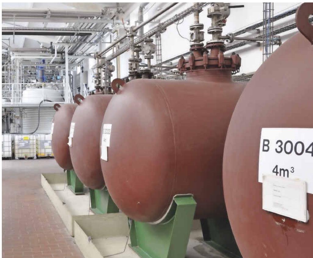
Bild 1: In verfahrenstechnischen Anlagen gibt es viele Druckbehälter, die ausgelegt werden müssen. Die Frage ist nur, nach welchem Regelwerk.
