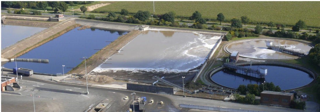
Abbildung 5.1.1: Absetzteiche Rübenwaschwasser Nordzucker AG, Werk Uelzen, Quelle: Nordzucker AG
