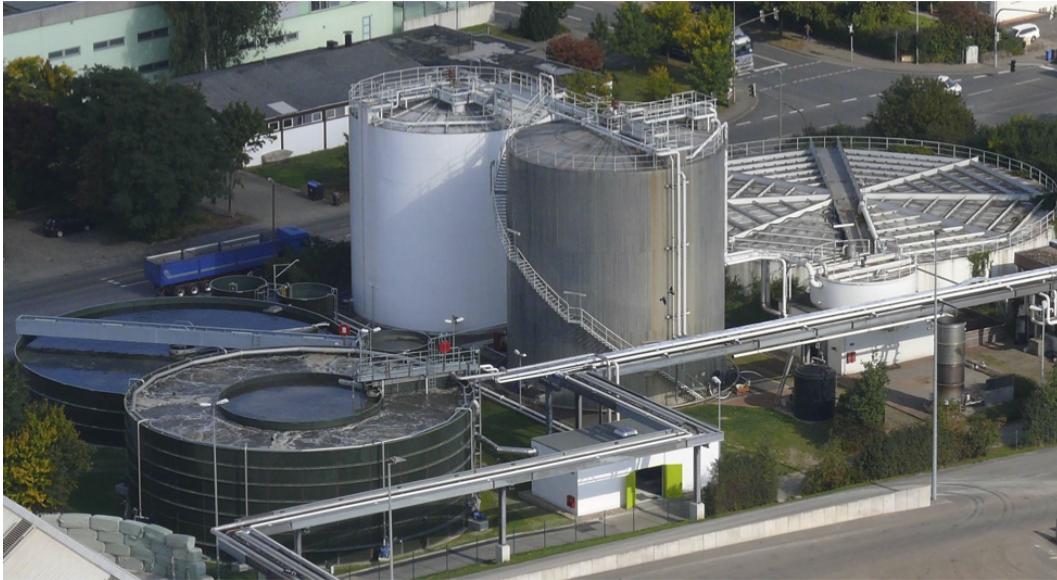
Abbildung 5.1.2: Biogasanlage Nordzucker AG, Werk Uelzen, Quelle: Nordzucker AG
