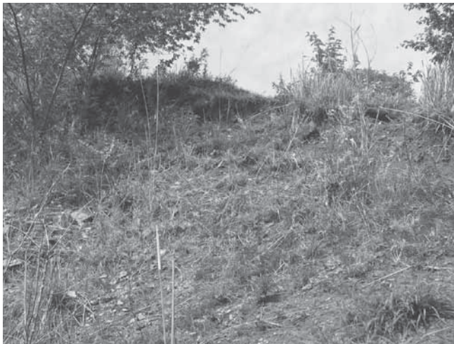
Figura 5. Deslizamiento en las vecindades de La Avellana.
