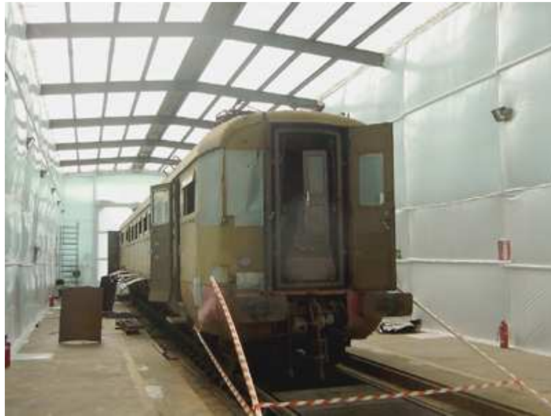
Figura 2.3: Bonifica da amianto su treno (da http://www.costaman.it )
