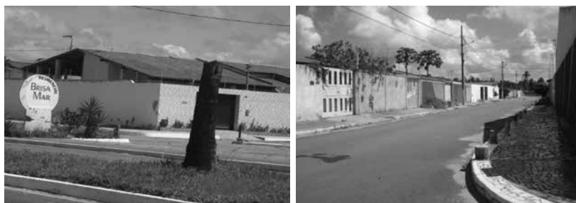
Fotografías N° 1 y 2 Conjunto Residencial del PAR
