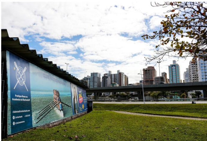
Imagem N° 27: Viaduto Região Rita Maria (Registro do meu acervo pessoal. Agosto de 2018)
