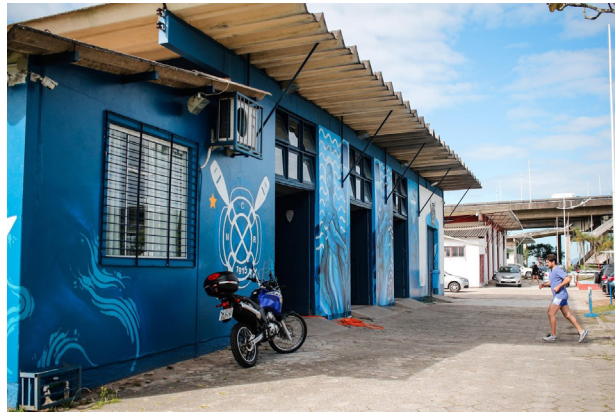
Imagem N° 28: Fachada dos galpões dos clubes de remo de Florianópolis. (Registro do meu acervo pessoal. Agosto de 2018.)
