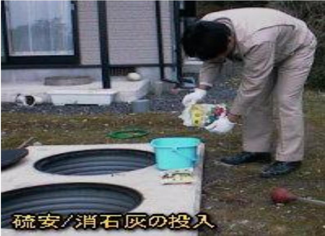
写真 8. 浄化槽内のサカマキガイを硫酸で除去する様子
