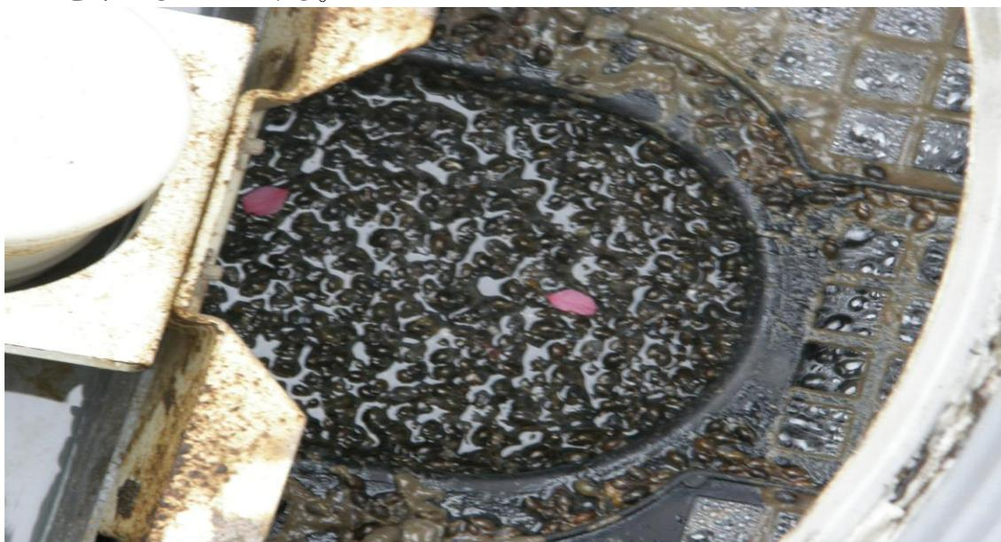
写真 3. 浄化槽内で増殖したサカマキガイの様子
