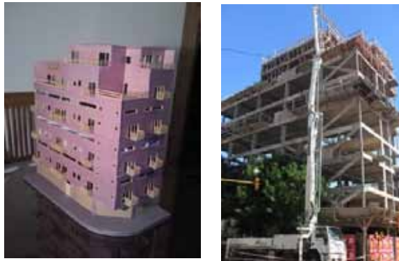
Imagen 5: Obra de la Cooperativa 1° de Mayo –MVT- Carlos Calvo 2801 (San Cristóbal). 21 Viviendas.
