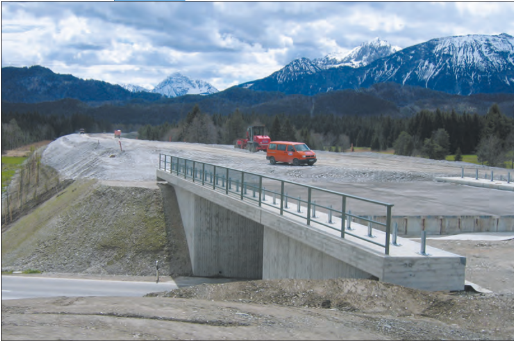
Abbildung 3: Neubau eines Autobahnteilstücks (Foto: Ina Oswald)
