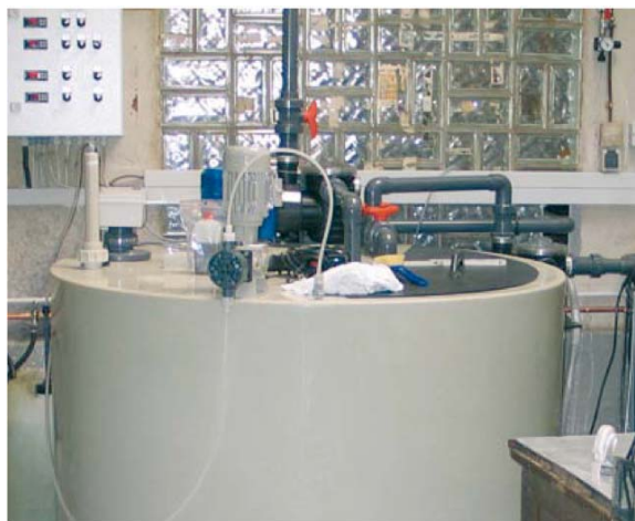
Abbildung 18: Das neue Kühlungssystem spart ca. 2.500 m 3 pro Jahr an Wasser, umgerechnet 5.000 Euro
