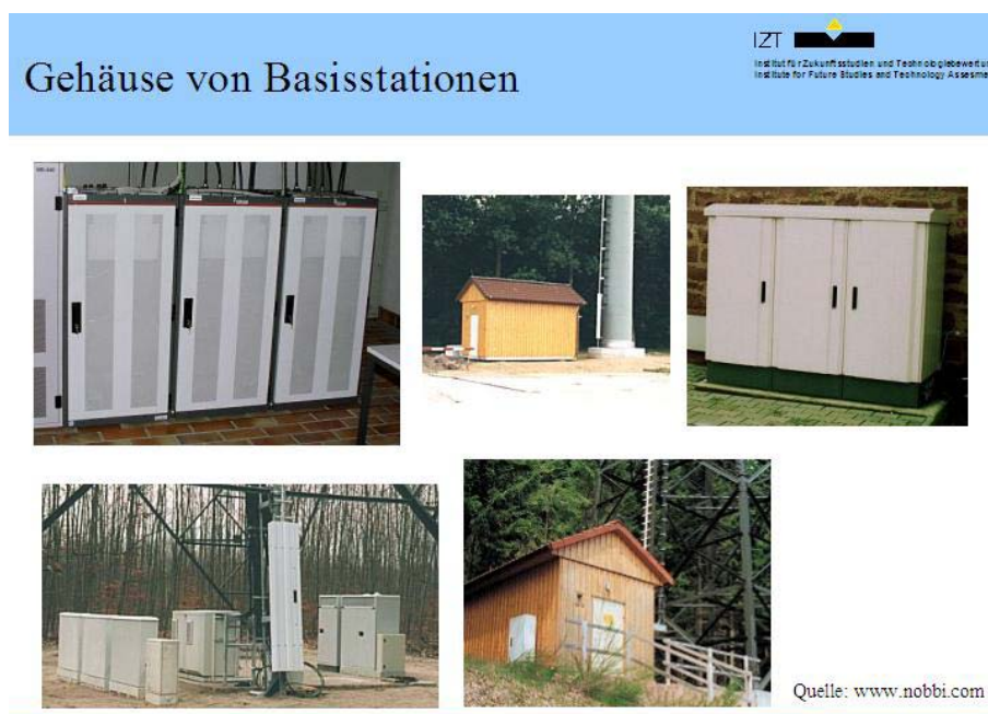
Abbildung 6: Gehäuse von Mobilfunkstationen.
