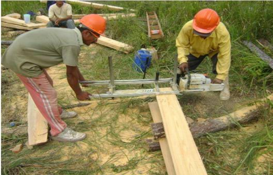
Foto 5: Aserrado de madera en Pie Tablar para construcción de vivienda, facilitada por José Soza, de Masangni
