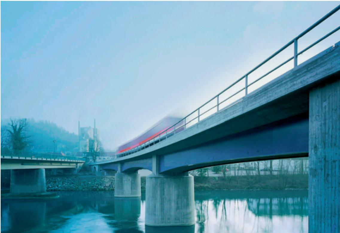
Abbildung 4: Eisenbahnbrücken aus Stahl-Verbundfertigteilen: Lech-Brücke in Schongau.
