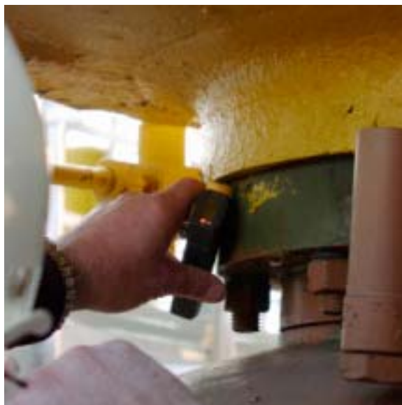
Foto 7: Screening von Armaturen mit Jansky Detektor.
