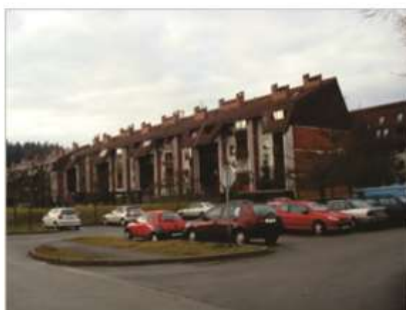
18 Stanovanjski bloki z asfaltiranim parkiriščem, parkiranimi avtomobili in zelenico
