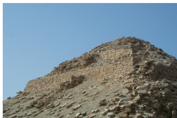
Sichtbare Kernstufenstruktur bei der Pyramide des Nefereirkare (5. Dynastie) in Abusir
