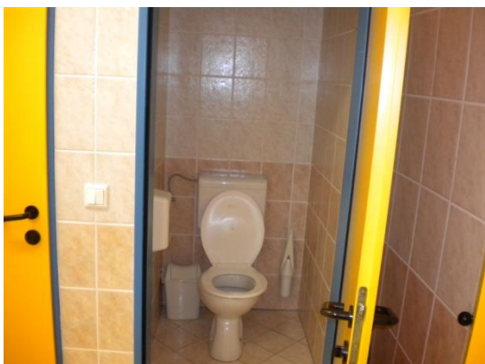
Slika 24: Primer neustreznih sanitarij za učenca, ki je gibalno oviran (vir: arhiv K. Vardič, 2011).
