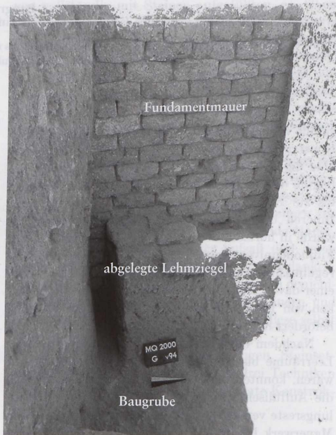
Abb. 5 Fundamentgrube in Raum B mit Arbeitsfläche und abgelegten, ungenutzten Lehmziegeln (Foto: Konrad Wita)
