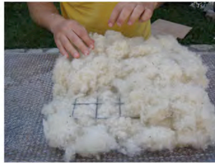
Paso 2 _ se cubre la capa superior con mas Blousse, tapando la malla metálica y sobrepasando los bordes.
