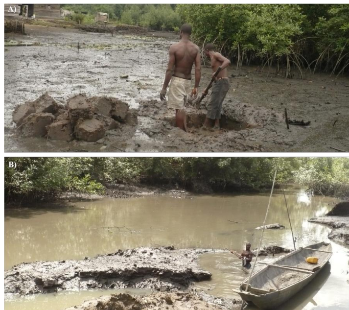
FIG. 8.5 (A) Excavation des sédiments dans une zone de mangroves périurbaines (périphéries de Douala (Cameroun)) ayant fait l'objet de coupes intenses. Les blocs de sédiments forés seront entreposés sur une zone de mangroves dévégétalisée. La hauteur de l'entrepôt atteint parfois un mètre. Ceci permet d'éviter les entrées d'eau dans les habitations surtout en période de grande marée de vives eaux). (B) Extraction du sable le long des berges d'un chenal assurant l'alimentation des mangroves en eau. Une bonne partie des palétuviers ainsi que des sédiments ont été enlevés. Avant le début de l'extraction, la pirogue est immobilisée à l'aide de deux petites tiges issues de la coupe des Rhizophora spp. Le sable boueux collecté sera par la suite lavé et tamisé afin de soustraire les sédiments, éléments grossiers et certains débris végétaux (surtout les racines mortes).
