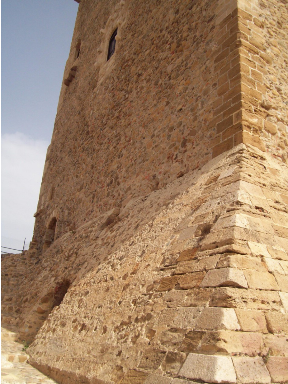
Fig. 5 - Veduta esterna del primo livello lato ovest dove insistono l'ingresso alla cisterna, la nuova porta, una finestra piccola con rincasso nel muro esterno.
