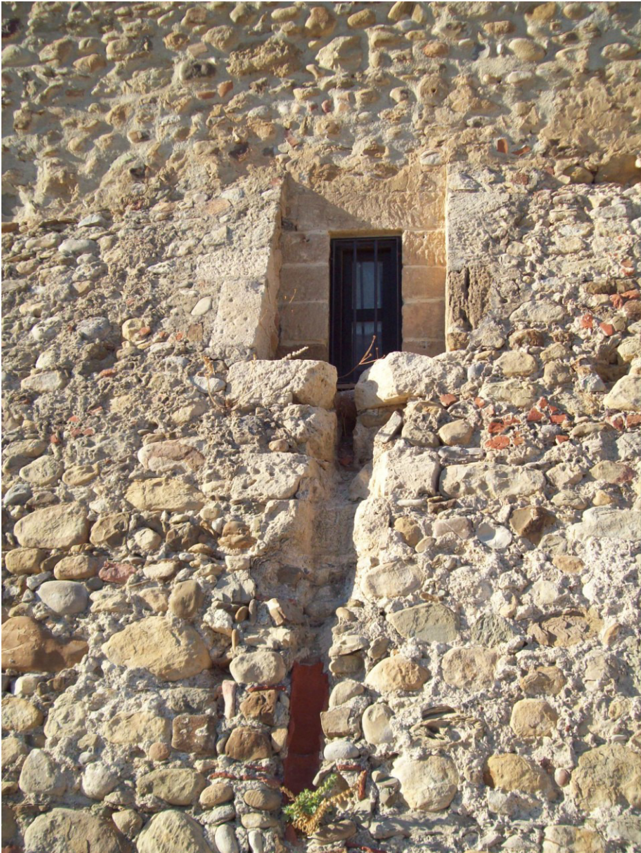
Fig. 3 - Finestra nella facciata sud con rincasso nel muro esterno.
