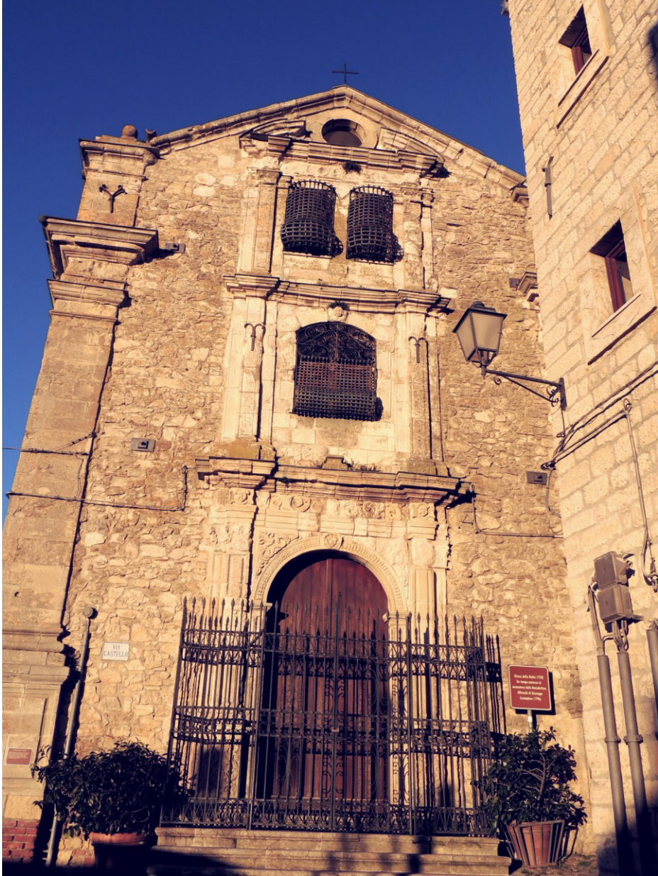
Fig. 3 - La chiesa della badia di Gangi.
