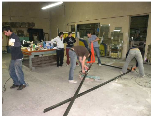
Figura 2: Primer etapa de fabricación de la estructura del trailer.
