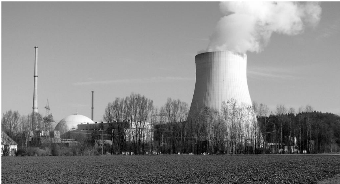
Atomkraftwerk Isar II
