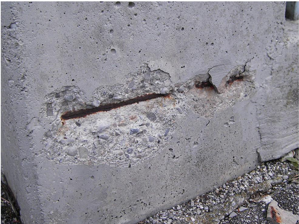
**Abb. 3.10:** Korrosion an einer Stahlbetonarmierung.
