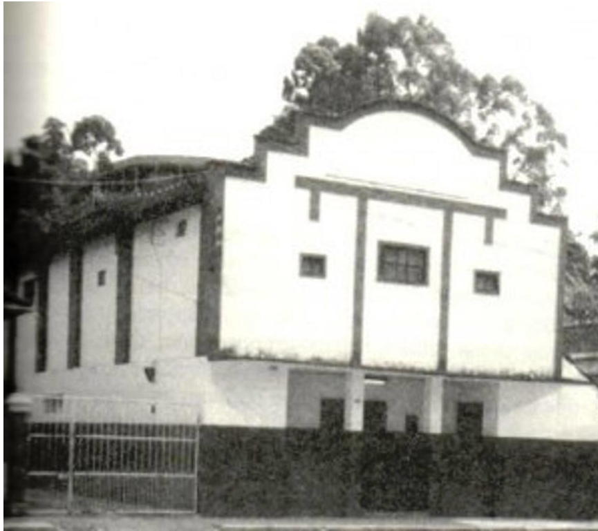
Figura 18 – Fotografia da construção onde funcionava o Cine-Theatro Paratodos
