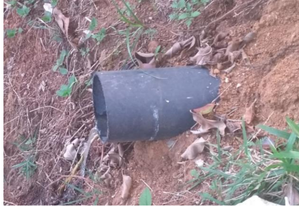
Figura 46 – Dreno instalado na vaga experimental. (Fonte: Autor, 2018)
