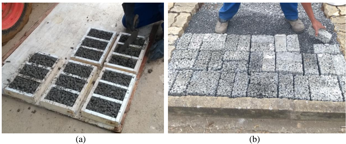
Figura 49 – Confecção (a) e assentamento (b) das peças de concreto permeável. (Fonte: Autor, 2018)
