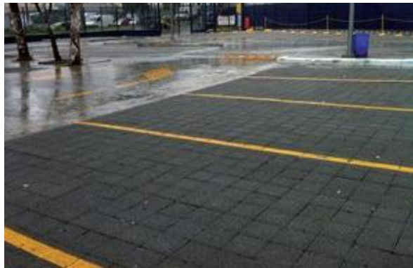
Figura 5 – Revestimento de pavimento constituído de placas de concreto permeável. (Fonte: Silva, 2012)
