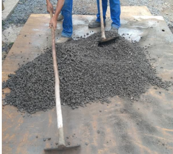
Figura 48 – Mistura dos materiais realizada manualmente. (Fonte: Autor, 2018)
