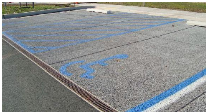
Figura 6 – Pavimento com revestimento de concreto permeável moldado no local. (Fonte: Marchioni e Silva, 2011)
