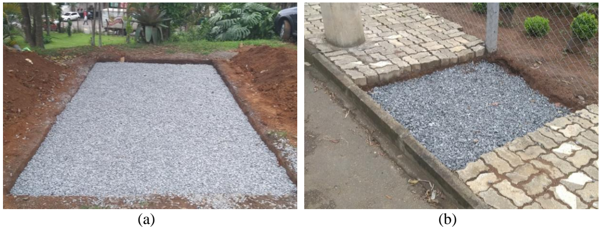
Figura 47 – Assentamento das camadas de sub-base da vaga (a) e do passeio (b) experimentais. (Fonte: Autor, 2018)
