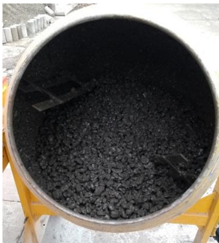
Figura 26 – Mistura dos materiais na betoneira. (Fonte: Autor, 2018)
