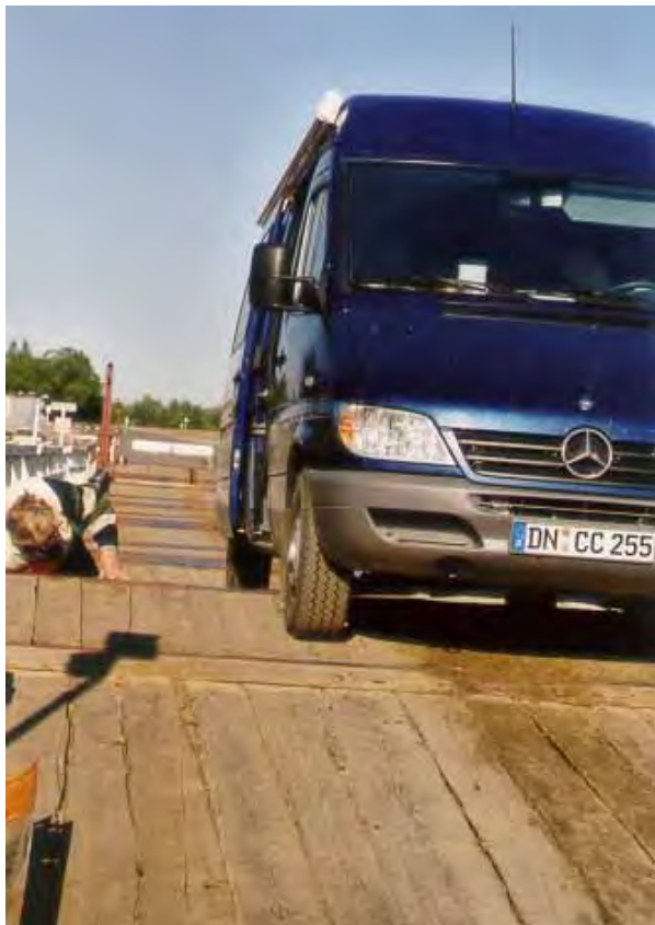
Abbildung 9.8: Neue Pontonbrücke über den Fluss Sosch
