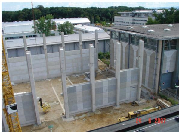
*Abbildung 3-6: Errichtung der Stahlbetonstützen und Einbau der Stahlbeton-Sandwich-Wandelemente*
