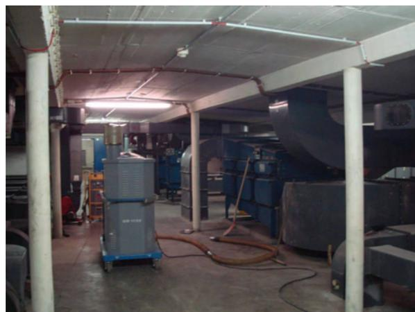
Abbildung 3-20: Lüftungsanlage im Dachgeschoss vor Demontage
