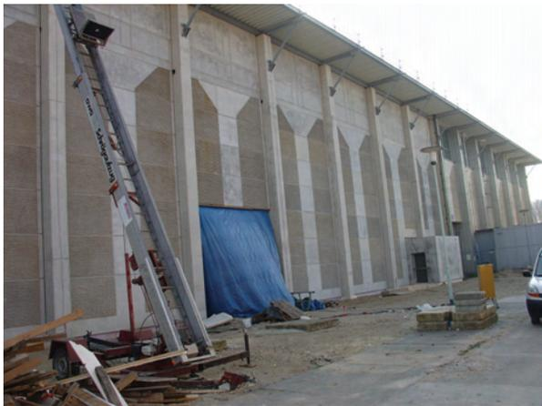
Abbildung 3-8: Erweiterung nach Montage der Dachdeckenelemente. mit durchgezogenem umlaufenden Dachüberstand
