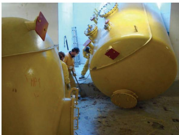
Abbildung 3-26: Demontage von Auffangbehältern
