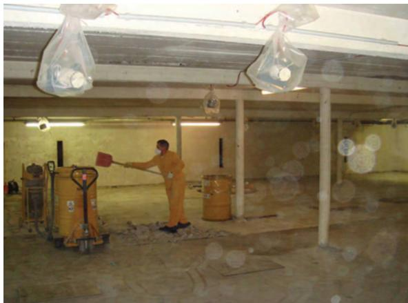
Abbildung 3-24: Entfernen des gesamten Estrichs im Dachgeschoss
