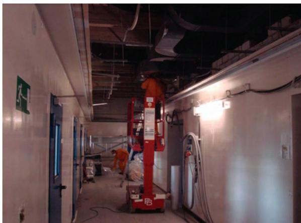
Abbildung 3-23: Demontage von Lüftungskanälen im Obergeschoss
