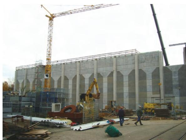
*Abbildung 3-7: Fertigstellung der Außenwände*
