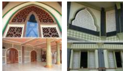
Gambar.3. Lubang ventilasi pada Masjid Jami'an An-Nur – Sidoarjo Masjid As'saadah Keputih, Surabaya. Sumber : http://lubangangin.com
