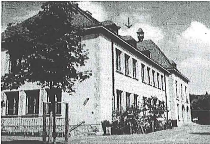
Bild 9: Südwestansicht der Grundschule Randersacker. Der Pfeil deutet die Lage des Erweiterungsbaus an, der in diesem Projekt umgerüstet wird.
