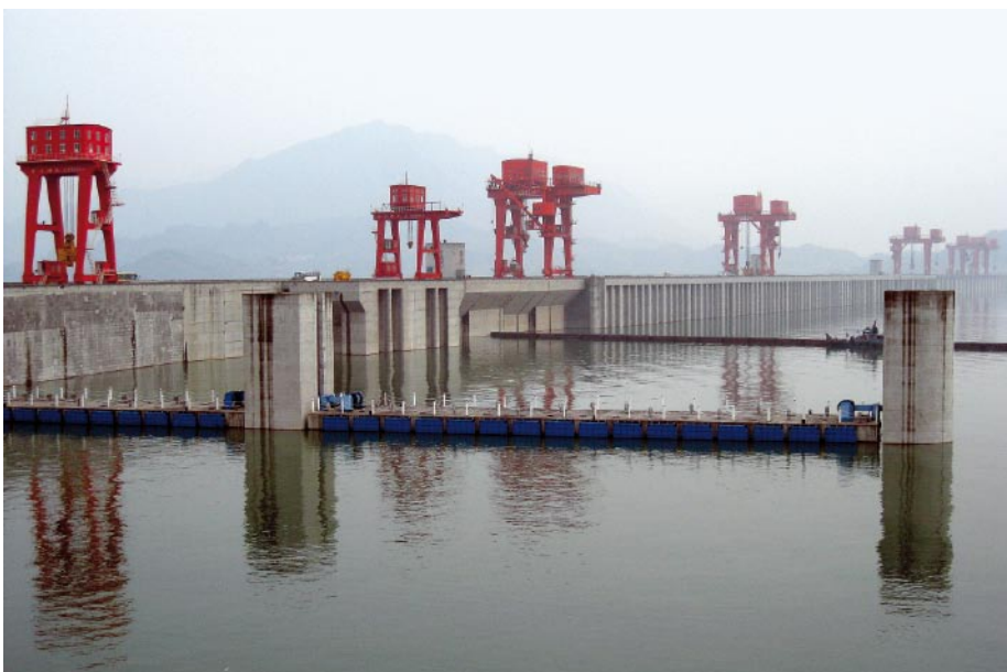
Abb. 3: Die Staumauer des Yangtze (wasserseitig)
