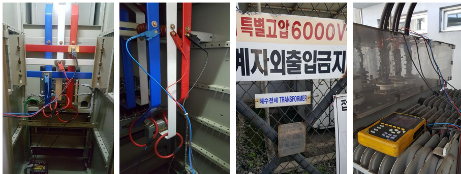
그림 3 전력품질 계측 사진[해수전해설비]
