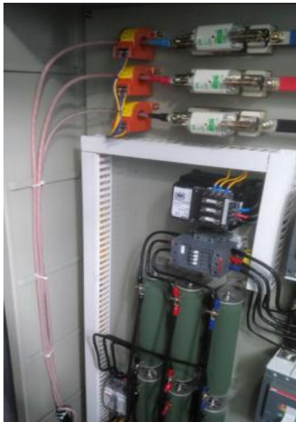
그림 68 MMC형 능동필터 연구제품 설치(파워케이블 및 CT 설치)
