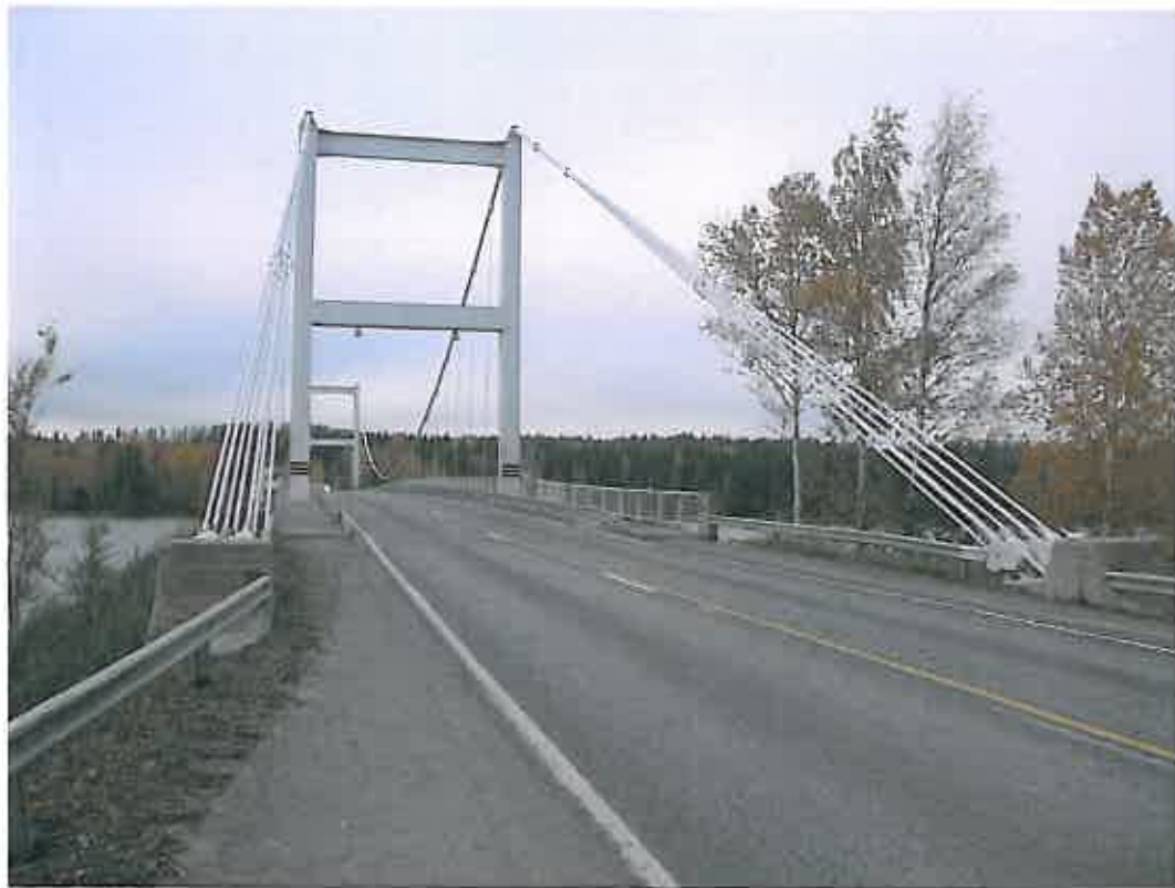
Figure 5.1. Hännilänsalmi suspension bridge in Viitasaari.
