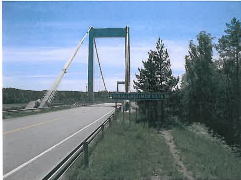
Figure 3.1. Kirjalansalmi suspension bridge in Parainen.
