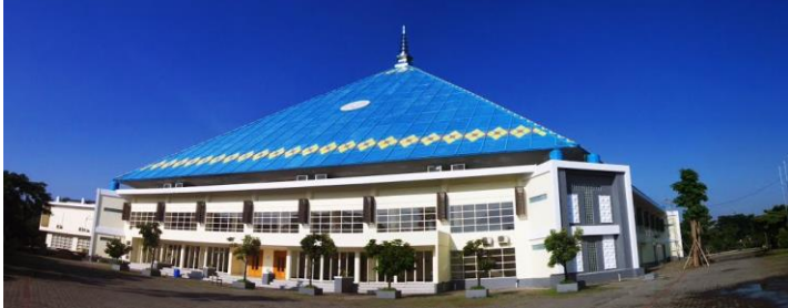
Gambar 3.2 Lokasi pengukuran (Gedung ACC)
