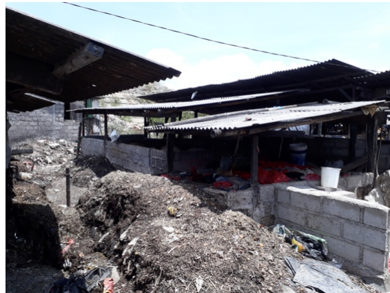
Gambar 2.7 Foto kondisi eksisting (sumber: dokumentasi pribadi)
