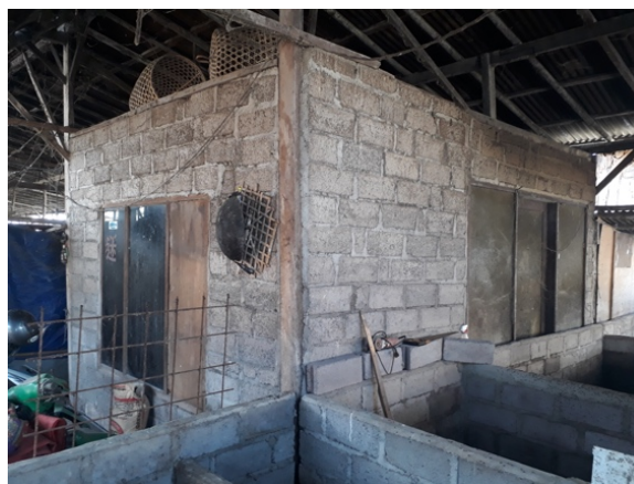
Gambar 2.8 Foto kondisi eksisting (sumber: dokumentasi pribadi)
